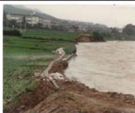
石川昭和橋上流右岸 富田林市彼方 (S57)
